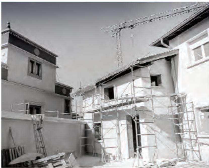
Pour le choix des matériaux, le sous-sol est en béton, le rez-de-chaussée et le 1er étage en briques, dont l'épaisseur importante (38cm) assure à elle seule l'isolation thermique.
